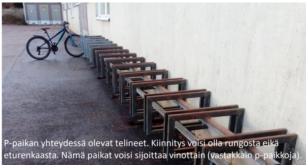
Ulko-oven edessä olevat telineet: ei katettuja, kiinnitys eturenkaasta ei rungosta.
