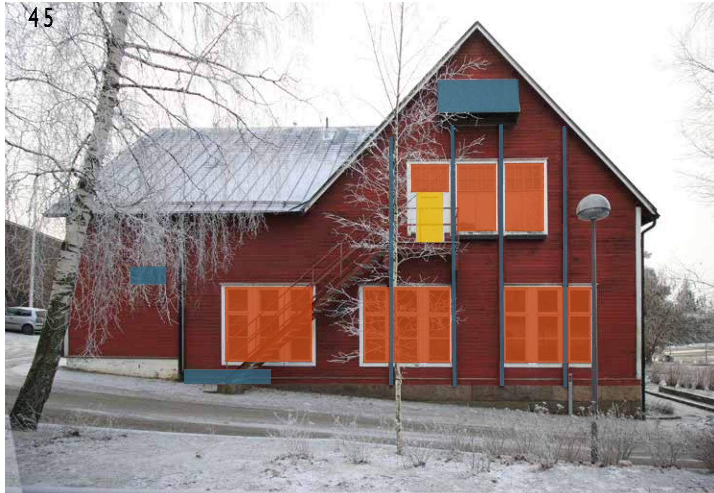
Pohjoisjulkisivu Näyttämön yläpuolinen kate jiiiriin asti 1990-luvulta.
