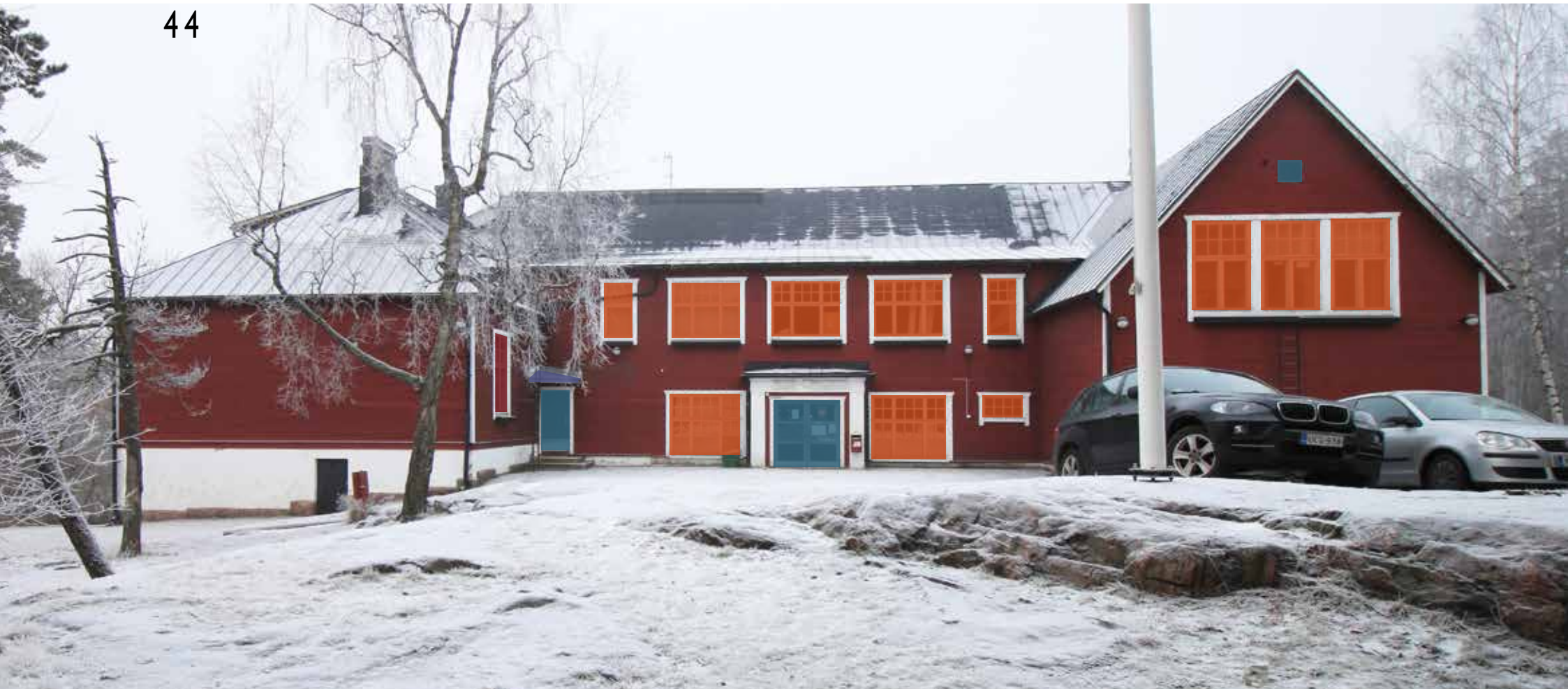
Itäjulkisivu Vesikate 1977-1980. Näyttämön yläpuolinen kate jiiriin asti 1990-luvulta.
