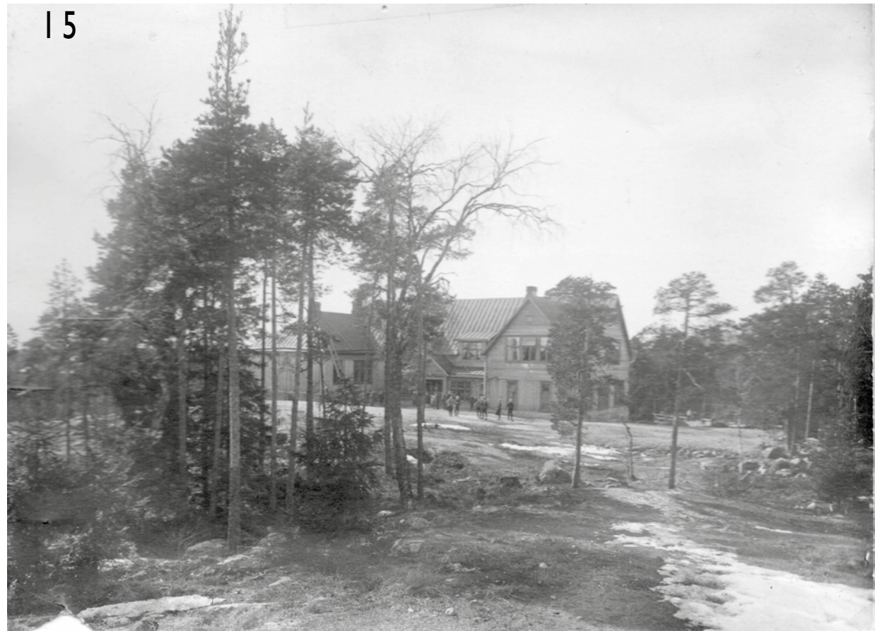
15 Vuoden 1912 laajennusosa ennen julkisivujen verhoilua. Myös vanhin osa on vielä hirrellä. Pystyhirsirakenteen ja lamasalvotun hirren vaihtelu näkyy valokuvasta. Kuva Kauni-aisten kaupunki.
